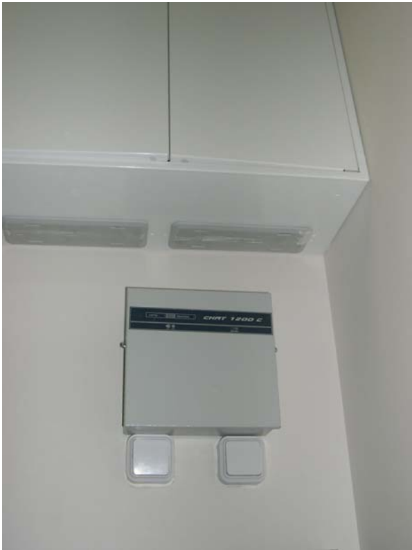
Вариант установки БП с клавишами управления системой
