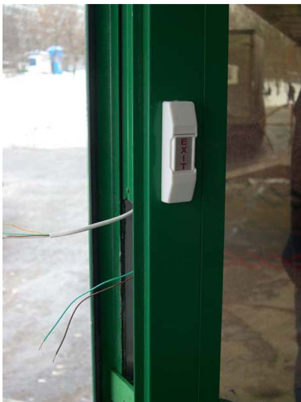
Монтаж «Кнопки Выхода» на плоскость двери (дверной коробки)
