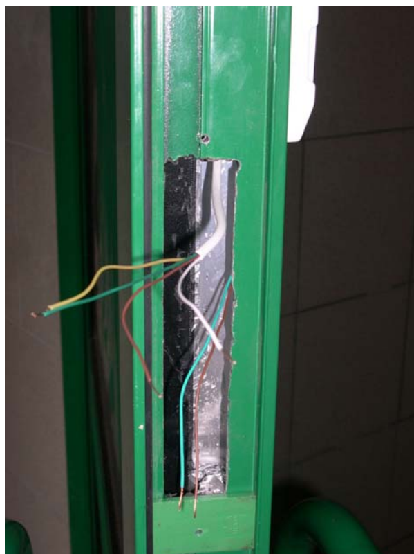
Подготовка в торцевой части дверимонтажного отверстия под э/магнитный замок
