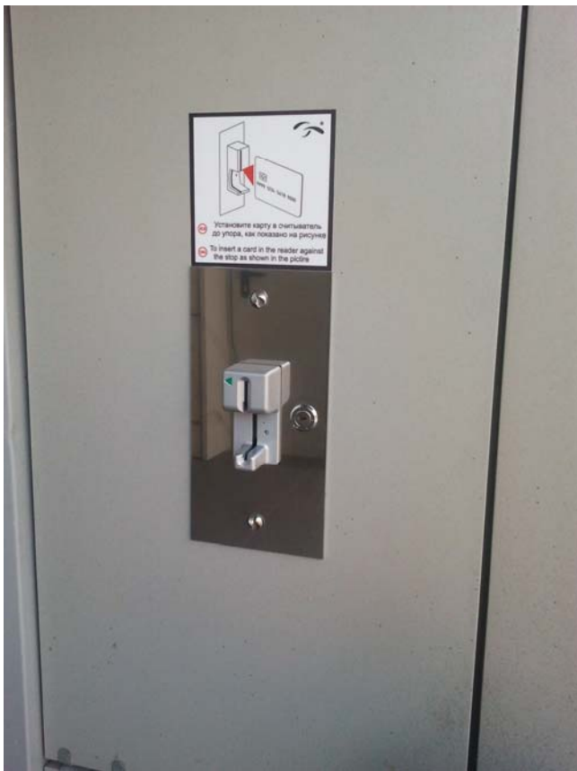
Внешний вид установленной панели со считывателем
