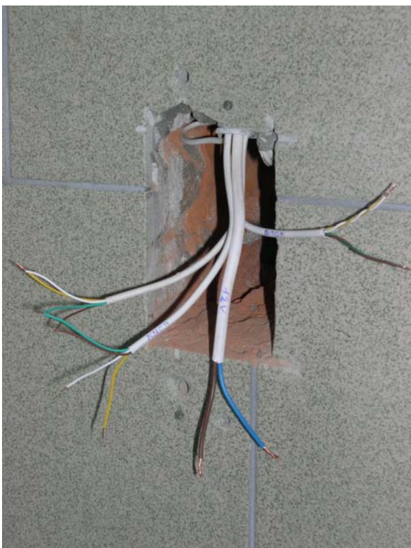
Выполненное в фасадной части стены монтажное отверстие под считыватель
