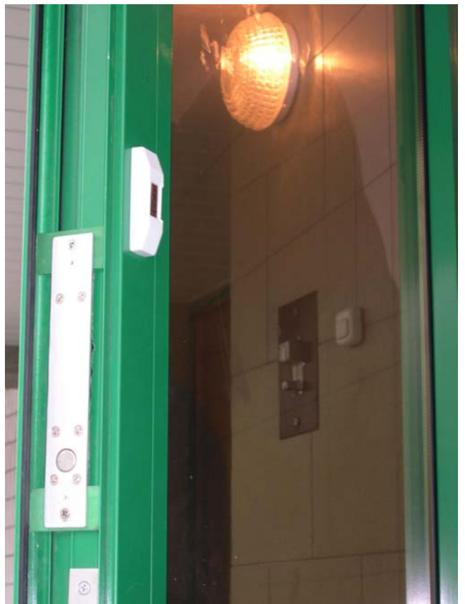
Внешний вид элементов системы Привратник тельно входной двери Объекта
