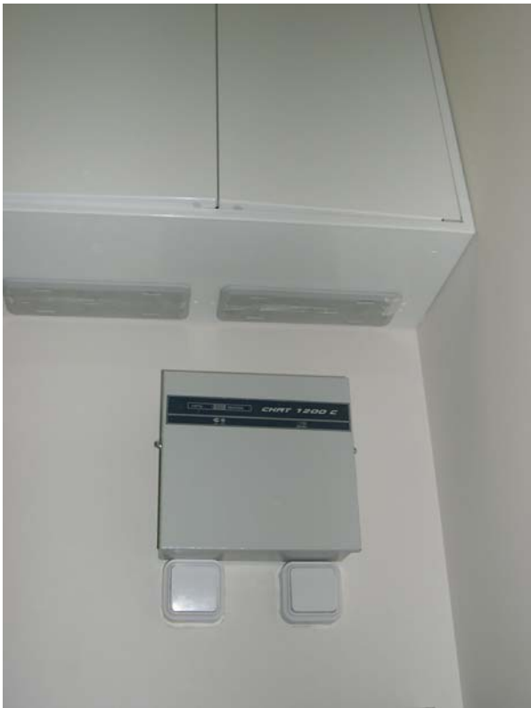
Вариант установки БП с клавишами управления системой
